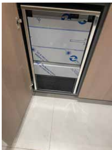
Instalación dentro de un armario bajoencimera - Modelo NG30 AGUA
